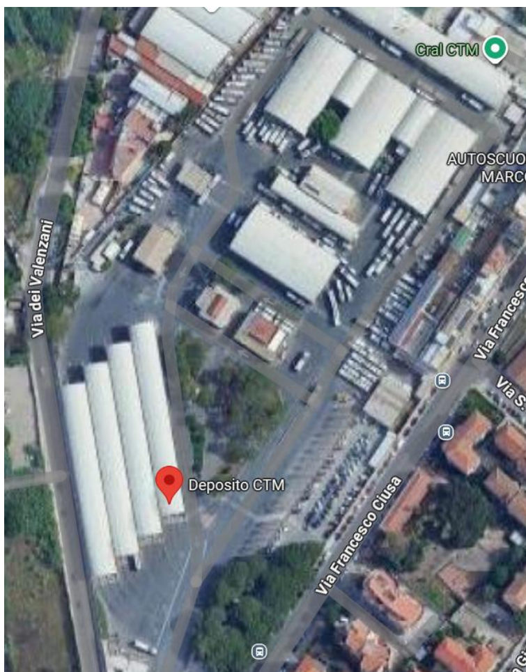
Ubicazione Sede CTM SpA presso Via Ciusa-Cagliari
